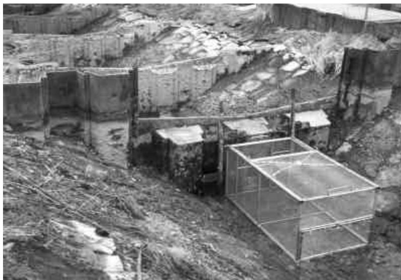
Abb. 2.2: Installation der Kastenreuse im Fischpaß Landesbergen
